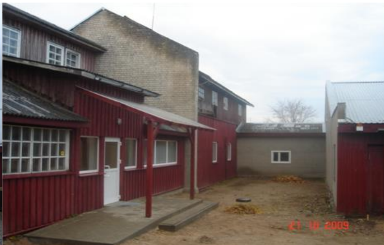
TĀDU PĀRBŪVĒJĀM LĪDZ 21.10.2009.
